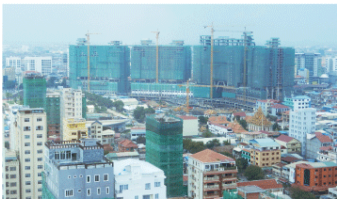
建設業はカンボジア経済の重要な成長エンジンとなっている＝10月、プノンペン（筆者撮影）
